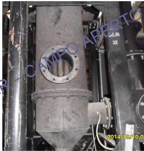
5- Scambiatore di calore , di tipo aria-gas, per l' abbattimento della temperatura in uscita da ca. 550 C° a ca. 200 C°
