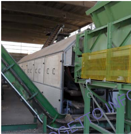
1-Sistema di caricamento ed essiccazione del cippato in ingresso
